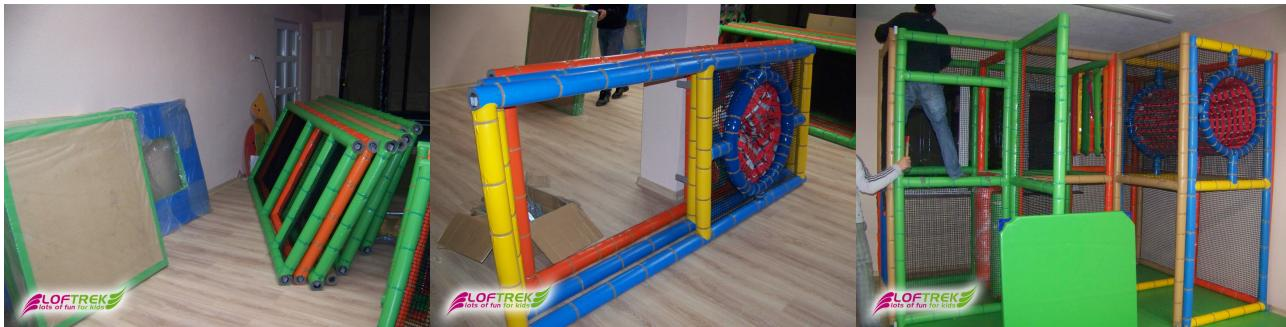
Sistemul bazat pe panouri în schimb vine cu panouri gata finisate, cu buretele și plasa preinstalate pe tevi. Instalarea devine mult mai simplă. Puteti să va imaginati că la o casă vin peretii prefabricați cu tot cu gresie și faianta și doar se asamblează ca un joc Lego.
